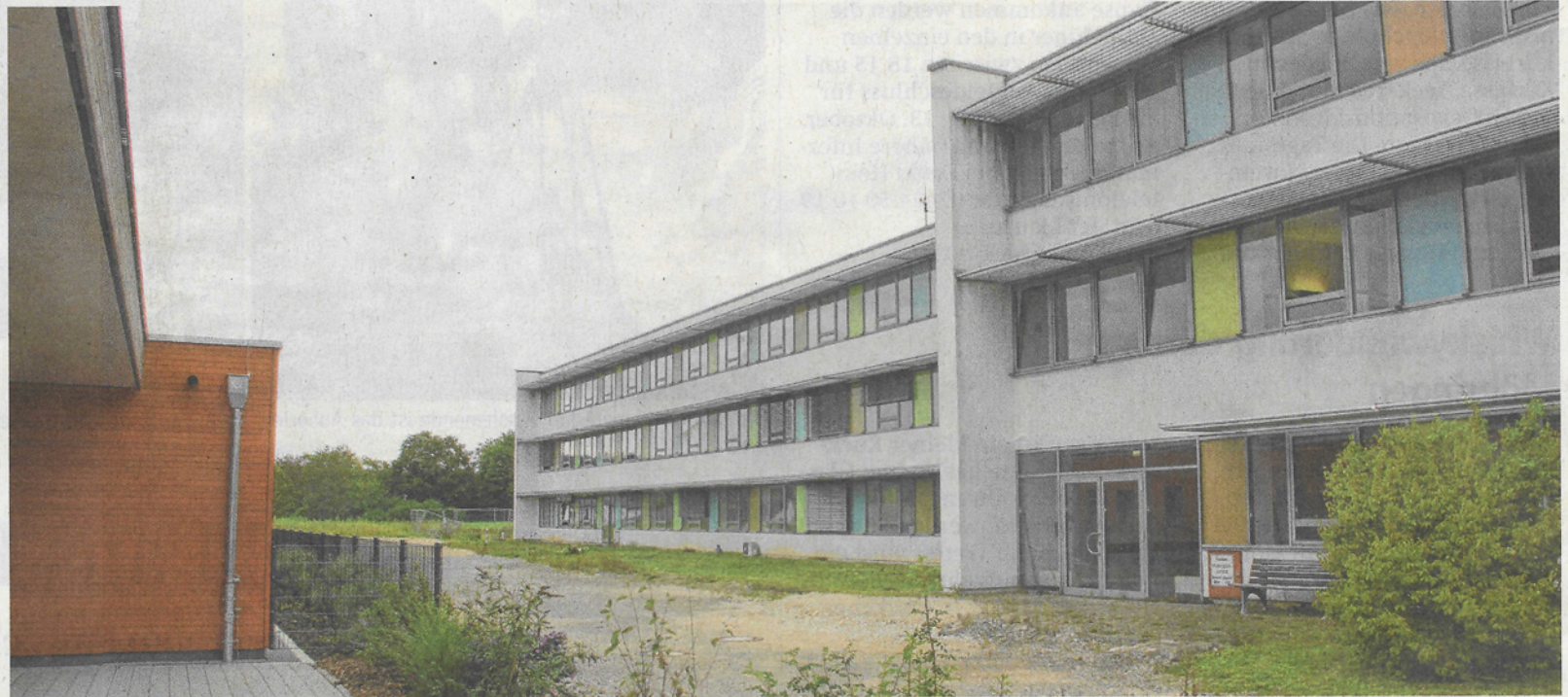
Dieser Riegel des Gesundheitszentrums soll nach den Plänen des Kreises erhalten bleiben. Geplant ist dort der Ausbau der Gesundheitsversorgung. Der Kreis will sich vorsorglich die Unterbringung von Geflüchteten im Bebauungsplan genehmigen lassen. Der Gemeinderat berät am 25. September darüber öffentlich. FOTO: FAWA
